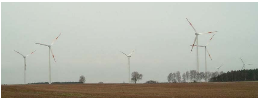
Abb. 1: Windpark Dahlenburg (18 × 2 MW). Weniger als 2 Jahre Entwicklungszeit reichten für eine fundierte, sorgfältige Planung einschließlich der Durchführung von Messungen am Standort aus.
