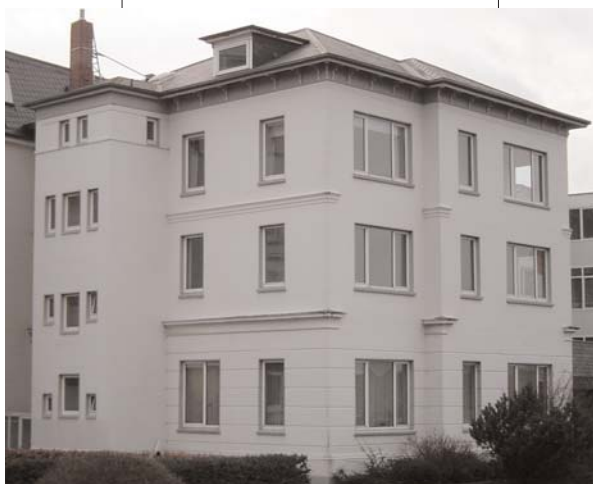
Abb. 1: Gebäude des DEWI-OCC in Cuxhaven
