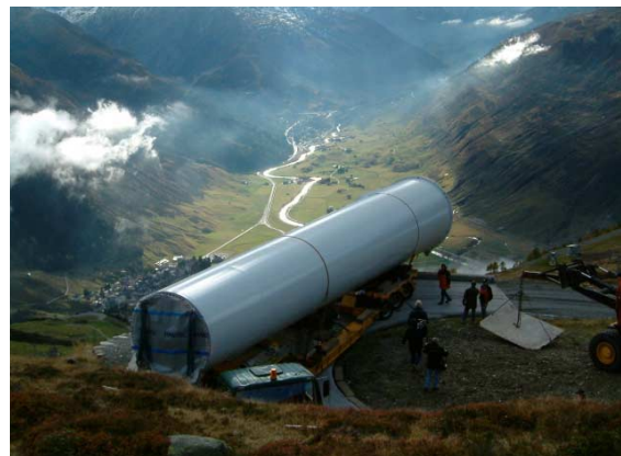
Abb. 1: Transport eines Turmsegmentes auf den 2.300 m hohen Gütsch bei Andermatt (Quelle: E-Werke Ursern, CH)
