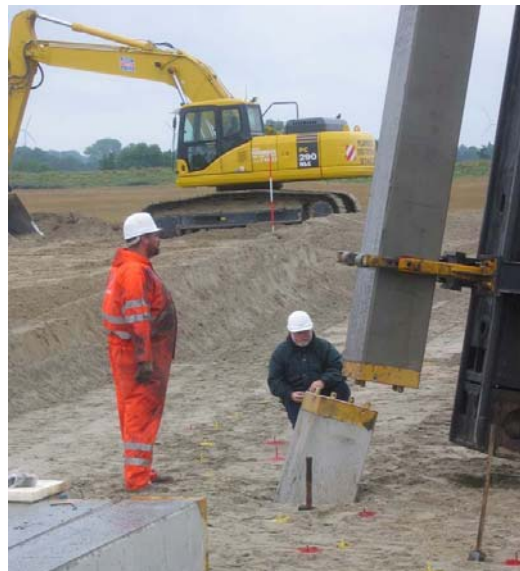
Abb. 1: Einer von 72 Pfählen für die Gründung der E-112 Fig. 1: One of the 72 piles for the foundation of the E-112
