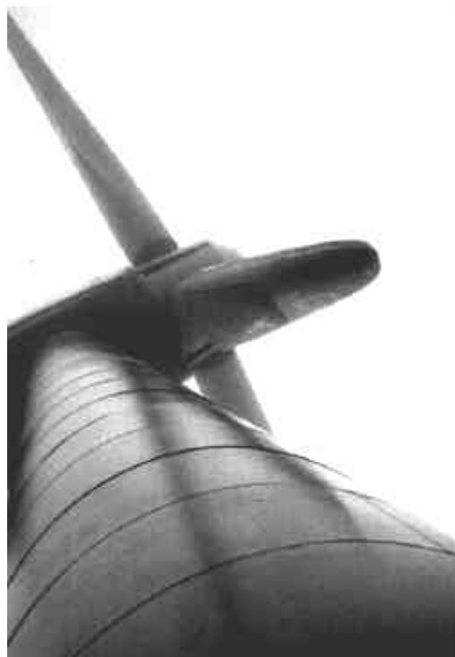
Abb. 1: 600 kW WEA mit Eisansatz Fig. 1: Wind turbine with ice accretion
