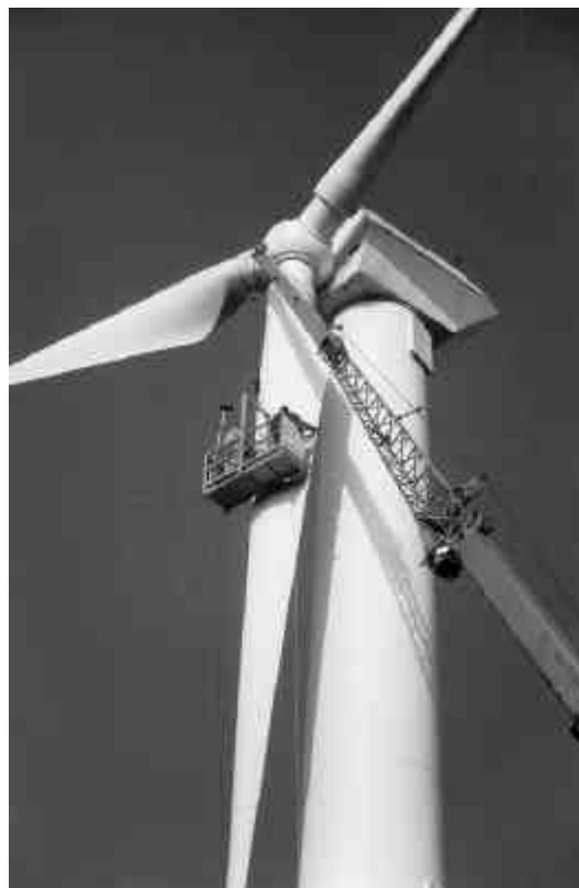
Abb. 3: Durchführung der Rotorblattreinigung
