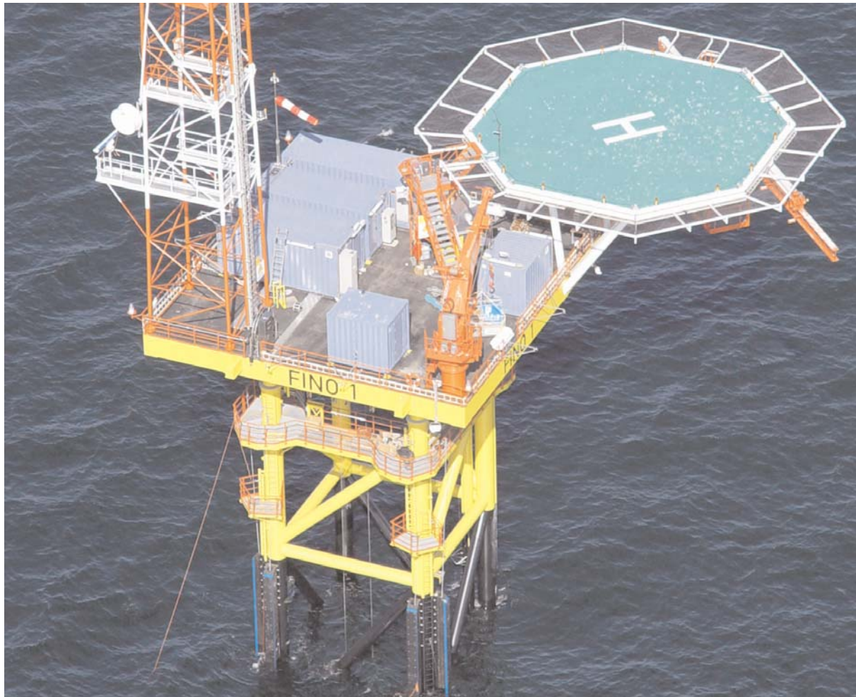
Abb. 5: Aufsicht auf die Plattform. Über dem Südpfeiler befindet sich der Windmessmast, diagonal gegenüber das Heli-Deck. Mit Hilfe des 5t Krans können auch schwere Lasten, z. B. einer der Container, bewegt werden. Unter der eigentlichen Plattform befindet sich ein Umlauf, von dem aus die hydrographischen Sensoren gewartet werden können.
