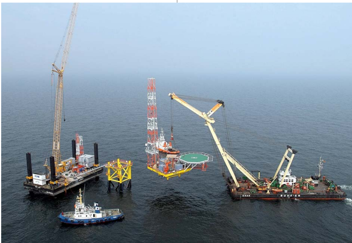
Abb. 1: Nachdem die Gründungsstruktur (Jacket) mit vier Pfählen in der Nordsee verankert worden ist, wurde das Oberteil der FINO1-Plattform mit den zwei ersten Segmenten des Windmessmastes sowie Apparate-Containern und Hubschrauberlandeplatz aufgesetzt.
