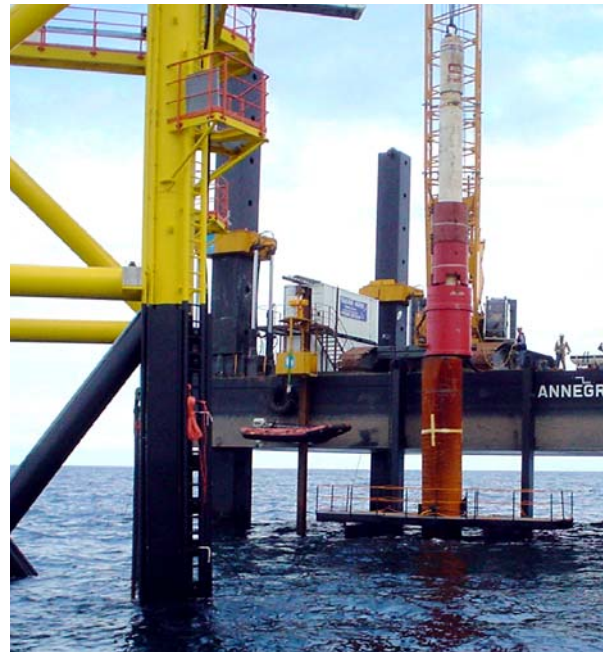
Abb. 10: Nach erfolgreichem Ausrichten des Rammpfahles kann dieser nun durch das Pile-Sleeve getrieben werden. Später wird der Pfahl im sogenannten "GROUTEN" mit Spezialbeton fest mit der Plattform verbunden. Am 4. Rammpfahl hat das DEWI in Zusammenarbeit mit der UNI Hannover und der UNI Oldenburg die beim Rammvorgang freigesetzten Schallenergien gemessen. In diesem weiteren vom BMU finanzierten Forschungsvorhaben sollen Verfahren zur Prognose der Lärmbelastung von Offshore-WEA, vor allem auch während der Bauphase, entwickelt werden.
