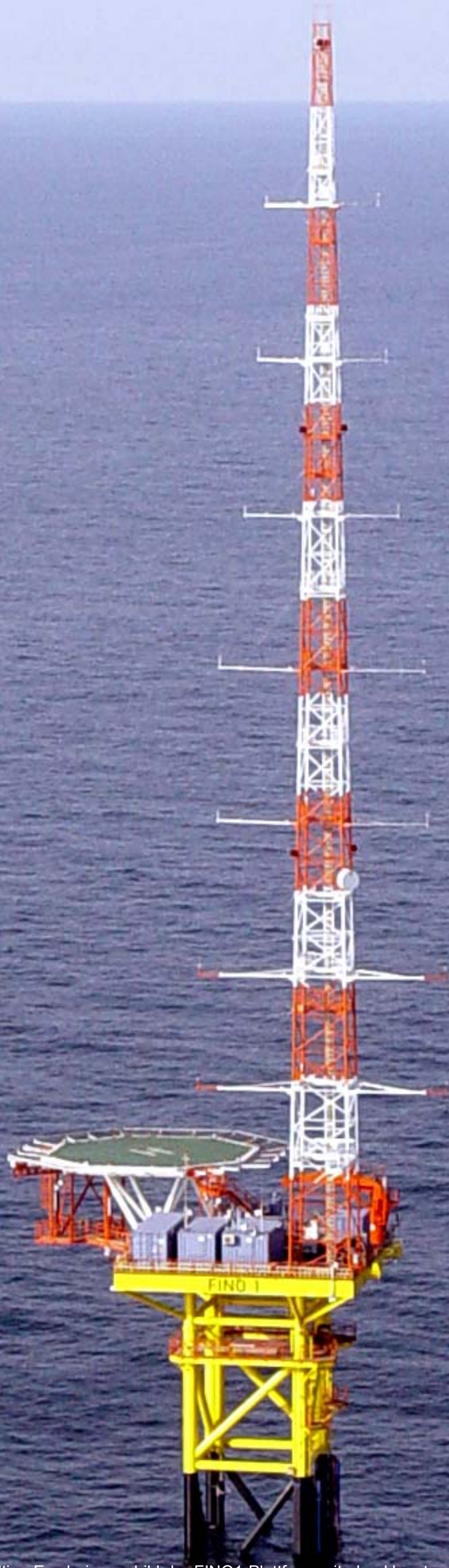
Abb. 2: Das endgültige Erscheinungsbild der FINO1-Plattform mit abgeklappten Auslegern für die Windmess-Sensorik. Fig. 2: The finished set-up of the FINO1 platform with jibs for wind measurement sensors in folded-down position.
