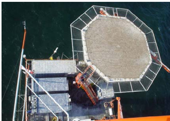
Abb 7: Blick auf die Windmess-Sensoren und das Plattformdeck im Oktober 2003. Deutlich ist die Verschmutzung der ursprünglich grünen Plattform durch Möwenkot zu sehen. Der Windmessmast und die Sensoren sind hiervon nicht betroffen. Ab November 2003 konnte ein deutlicher Rückgang der Verschmutzung beobachtet werden.
