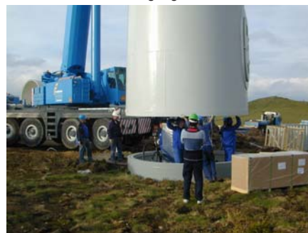
Abb. 8: Arbeit des Schwerlastkranes auf minimierten Bauflächen und Baggermatten
