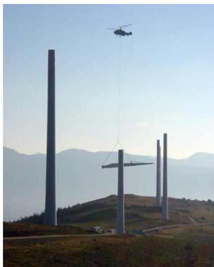
Abb. 6: Transport der Rotorblätter mit dem Hubschrauber
