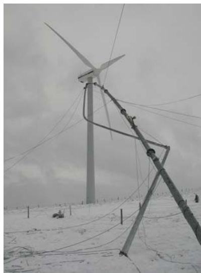
Abb. 11: Tonnenschwerer Schneeansatz an Mast und Seilen machen auch einem 65 m Messmast "schwer" zu schaffen.
