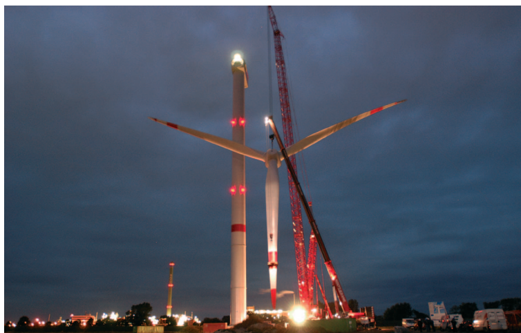
Abb. 1: Mit Spannung erwartet Cuxhaven den Aufbau einer REpower 5M auf dem Testfeld. Im Bild: der Aufbau der REpower 5M in Brunsbüttel.
