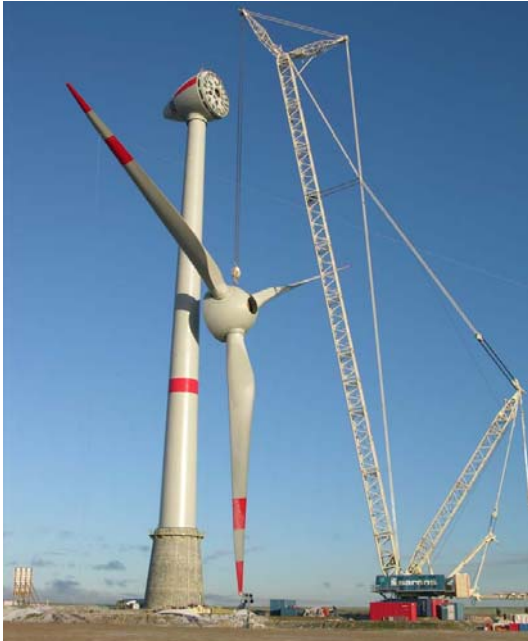
Abb. 3: Montage des Rotors im Dezember 2005 Fig. 3: Installation of the rotor in December 2005
