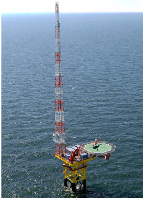
Abb. 3: Das Photo zeigt die Forschungsplattform FINO 1 in der Nordsee mit 100 m hohem Windmessmast und Hubschrauberlandeplatz. Hier werden Daten für die Planung künftiger Offshore-Windparks erhoben. (Quelle: Germanischer Lloyd WindEnergie GmbH)
