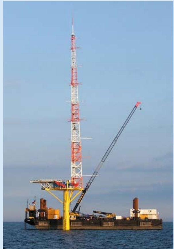
Fig. 5: The latest of the three FINOs is located about 80 km north-west of the North Sea island of Sylt (Source: FuE Zentrum, FH Kiel GmbH (Kiel University R&D Centre)) Abb. 5: Die jüngste der drei FINO-Schwester steht rund 80 Kilometer nord-westlich der Nordseeinsel Sylt (Quelle: FuE-Zentrum FH Kiel GmbH)
