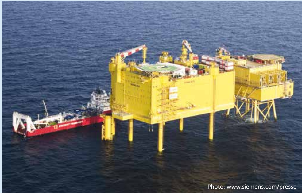
Fig. 5: Via the grid connection BorWin 2, 800 MW offshore wind power can be transmitted to the shore – Photo: Converter station BorWin beta in the North Sea directly next to the BorWin 1 platform (on the right) Abb. 5: Über die Netzanbindung BorWin 2 kann 800 MW Offshore-Windenergie an Land übertragen werden – Bild: Konverterstation BorWin beta in der Nordsee direkt neben der Plattform BorWin 1 (rechts)
